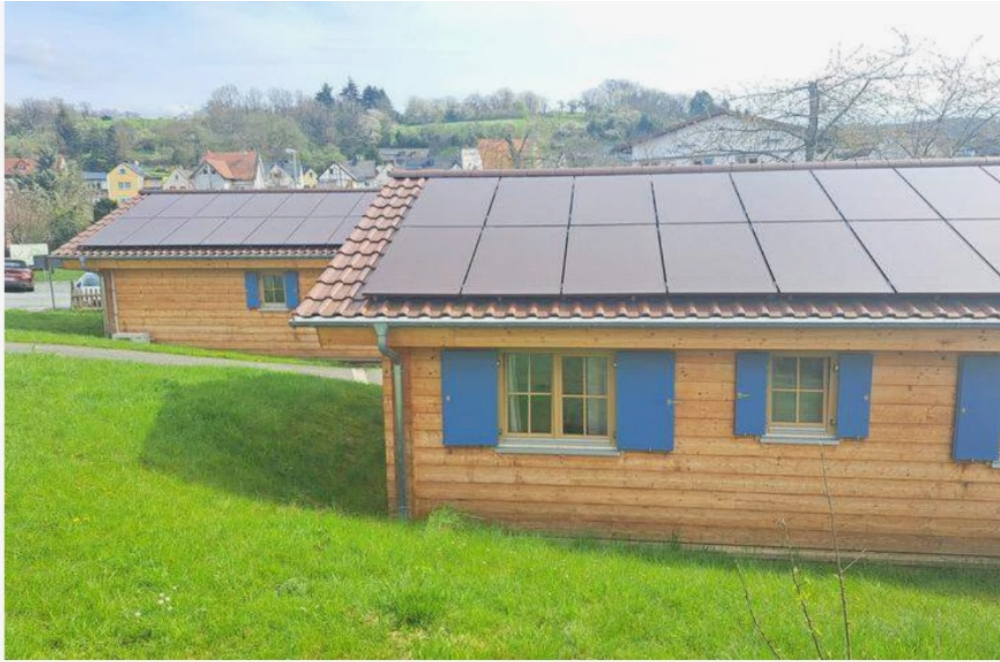
Durch die Photovoltaikanlagen auf den Dächern wird der Strom für das Hüttendorf selbst produziert. (© Tobias Ketter)
